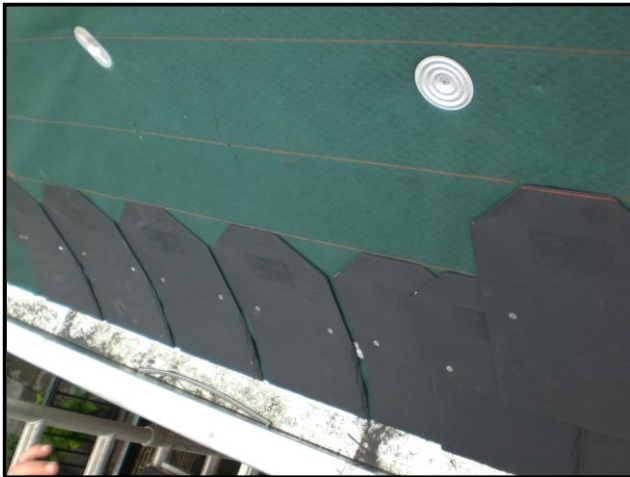
Voordeel aanbrengen krijtlijn
