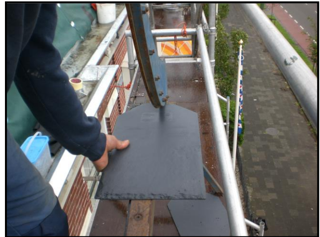
Snijden van de lei met slagschaar
