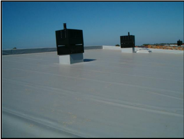
Evalastic: éénvoudig thermisch homogeen te lassen
