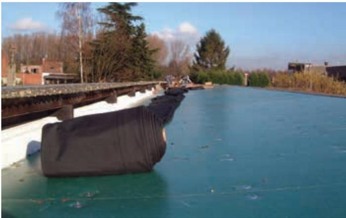
La taille maximale de la membrane préfabriquée dépend du poids que peut supporter la structure de la toiture.
