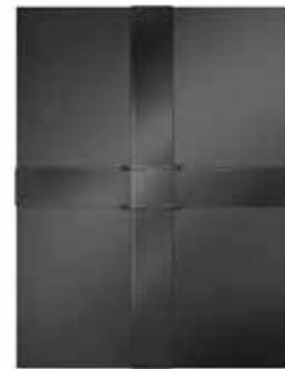
Lorsque les quatre membranes Prelasti forment une quadrillage, les disposer côte à côte sans recouvrement. La bande à souder Thermobond R doit être soudée à la membrane inférieure et le ruban Thermobond doit être soudé afin de compenser la différence d'épaisseur. Appliquer le ruban Thermobond de manière à ce qu'il dépasse d'au moins 10 mm de chaque côté sous la bande supérieure.
