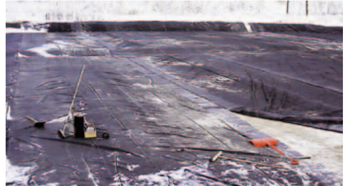
Installation av komposteringsyta vid Dåva kretsloppsanläggning i Umeå.
