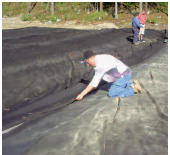
Övertäckning av deponi, Åsele. Beställare: Åsele kommun Markentreprenör: Åke Larsson Grävare Tätskiktsinstallatör: Åke Larsson Grävare
