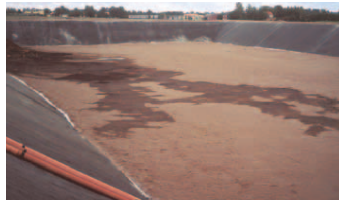
Bottentätning av deponi, Avesta. Beställare: Avesta Polarit Markentreprenör: NCC Tätskiktsinstallatör: Hedbergs Tak
