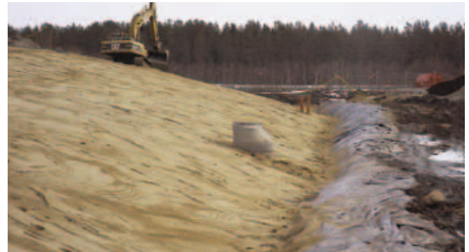
Slänttäckning vid Dåva industrideponi i Umeå.
