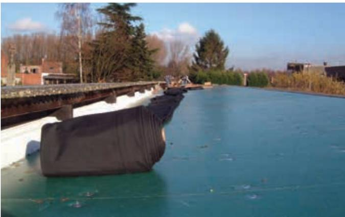
Es ist sowohl für die Sicherheit als auch für den Schutz der Plane selbst wichtig, zu berücksichtigen, wie diese gefalteten Planen am Standort des Gebäudes gehandhabt werden sollen. Der Absetzpunkt der gefalteten Plane auf dem Dach ist äußerst wichtig. Die entsprechenden Anweisungen zum Absetzpunkt und zum Entfalten/Abrollen werden mit den Planen mitgeliefert.
