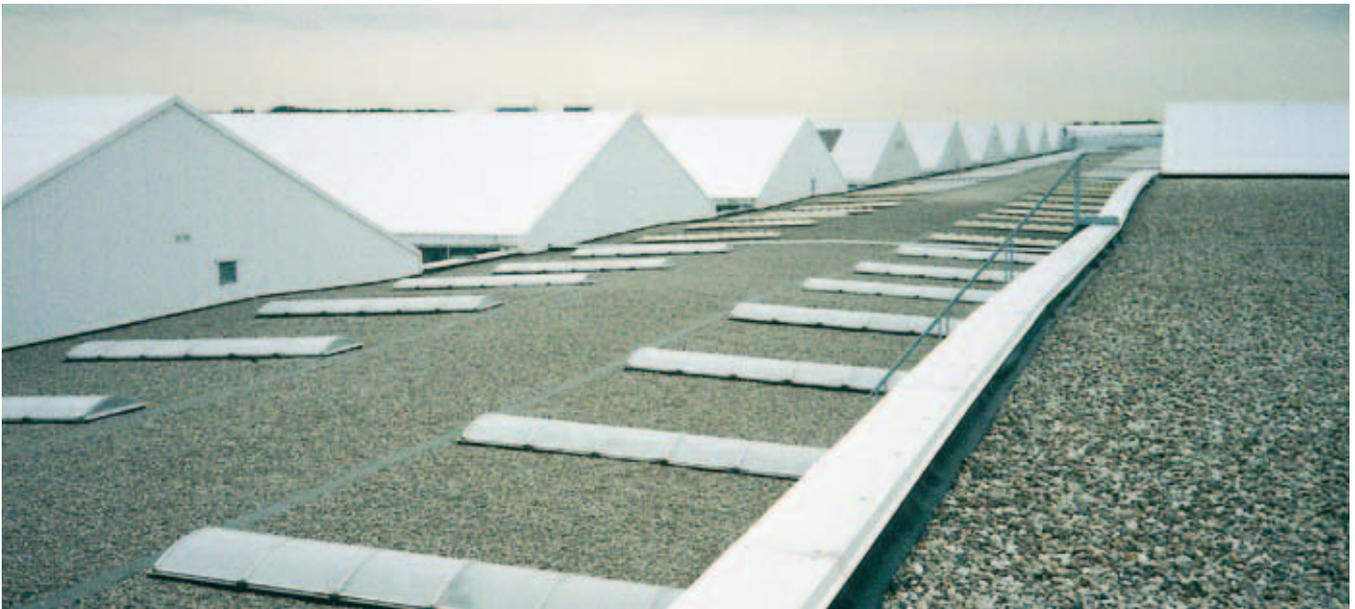
Auch Schon 1960 hat die Holländische Blumen Auktion Veiling Flora, das Dach Ihrer Auktionshalle in Rijnsburg, mit grossen vorgefertigten Kautschukplanen abgedichtet. In den letzten 20 Jahren wurde SealEco mit der Belieferung von EPDM Planen des heute über 250.000 m<sup>2</sup> grossen Daches beauftragt.
