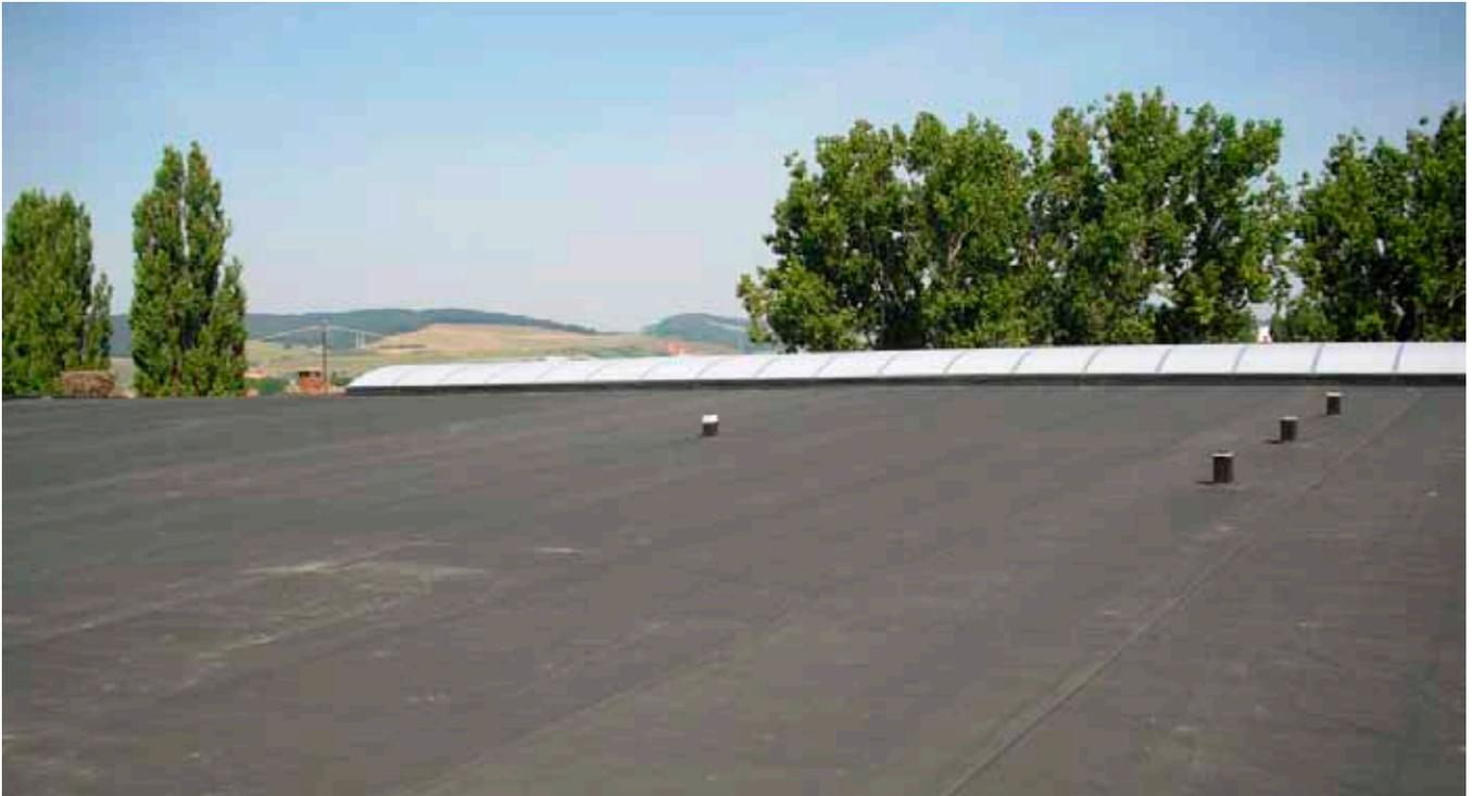
Das neue Eisstadium des Sportparks Marosvasarhely/Targu Mures wurde 2009 gebaut und das Dach wurde mit Prelasti EPDM abgedichtet. Beauftragt wurde hier das Bedachungsunternehmen EBE & CO S.R.L. Die Gesamtfläche des Daches beträgt 4370 m<sup>2</sup>. Das Dach wurde mit 8 vorgefertigten Prelasti Planen, je 550 m<sup>2</sup> groß abgedichtet. Die
