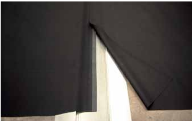
Positionera den andra dukvåden så att överlappet når dukmarkeringen på den första våden, vilket motsvarar ett 40 millimeters överlapp. De grå Thermobondkanterna ska mötas utmed dukarnas hela längd.
