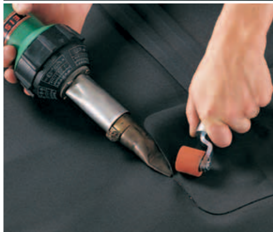
Prefab buisdoorvoeren and details worden gelast met warme lucht. Kwaliteitscontroles geschieden met hoge druk kanaallassen en persluchttesten.
