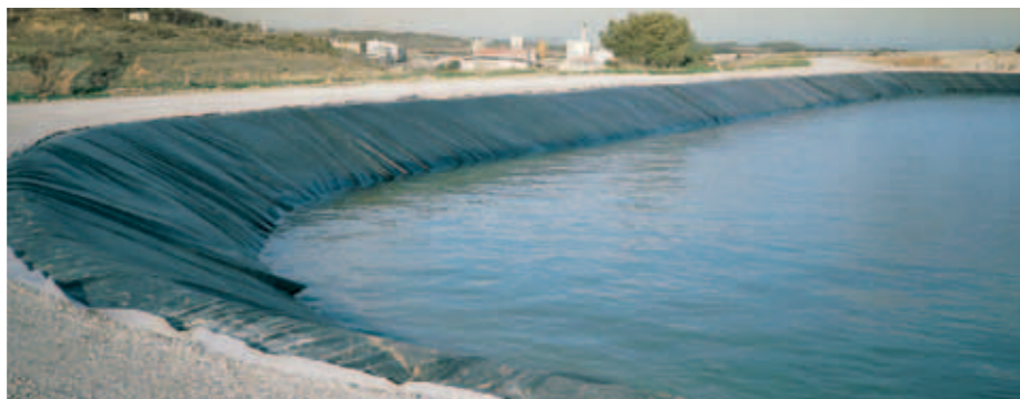
80.000 m 2 afvalwaterreservoir, Comurhex, Narbonne, Frankrijk
