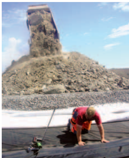
50000 m 2 industrieel afvalbekken, Swedish Steel AB, Oxelösund, Zweden
