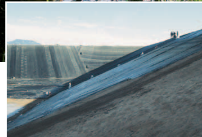
55000 m 2 Irrigatie reservoir, Vilena Alicante, Spanje
