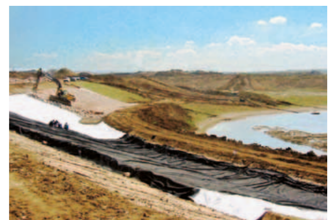
Termisk skarvning med värmekil
