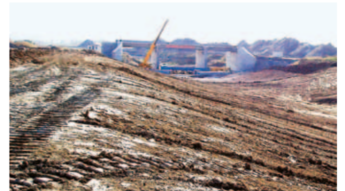
Ny flodbädd med betongbro
