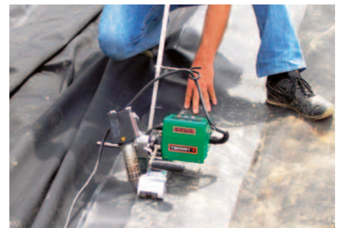
Termisk skarvning med värmekil
