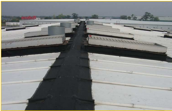
Przykładowe zastosowanie Elastofolu na dachu z płyt warstwowych – hydroizolacja połączenia w kalenicy.
