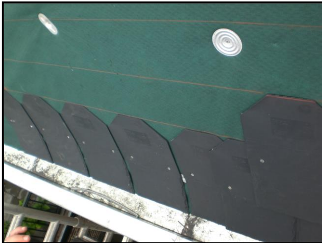
Voordeel aanbrengen krijtlijn
